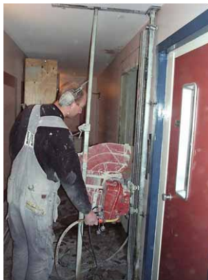
Monteringen gjordes utan att använda slagborrmaskin. Foto: Patrik Sjögren
